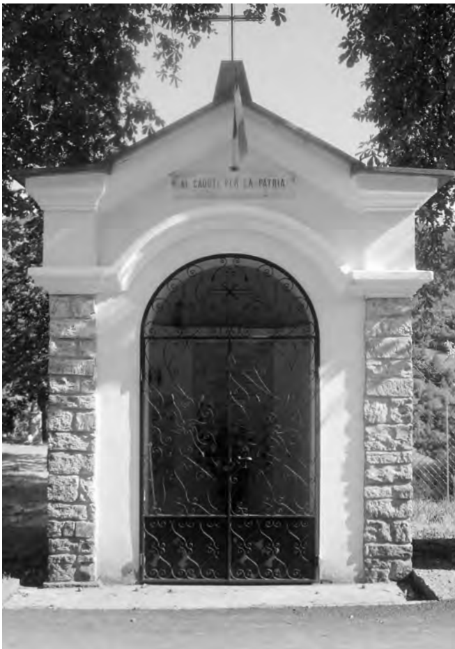
Bardi, Santa Giustina Val Lecca, strada provinciale Monumento a cappella, 1920-1923
